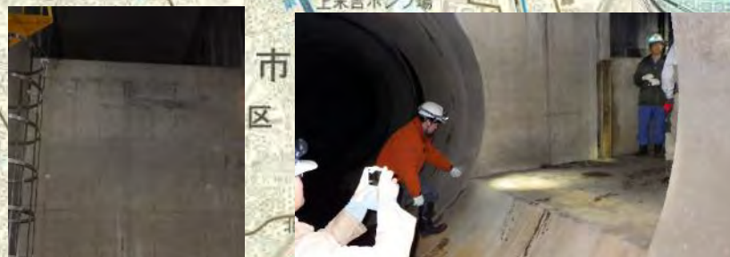
下水道管内水位観測の様子(GAIAプロジェクト)
